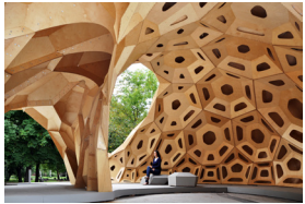
ICD/ITKE Forschungspavillon 2011. Architekten und Ingenieure: Team ICD (Prof. Achim Menges) und ITKE (Prof. Jan Knippers), Universität Stuttgart. (Bild: Team ICD/ITKE)
