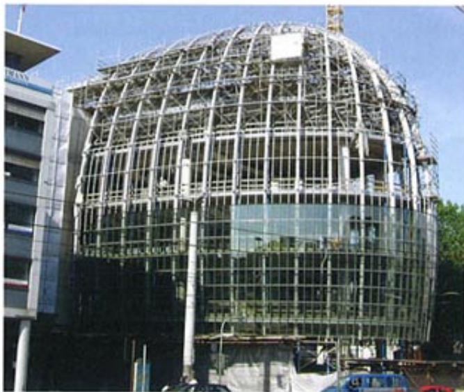
Bild 10. Montage des Tragwerkes Fig. 10. Erection of structure
