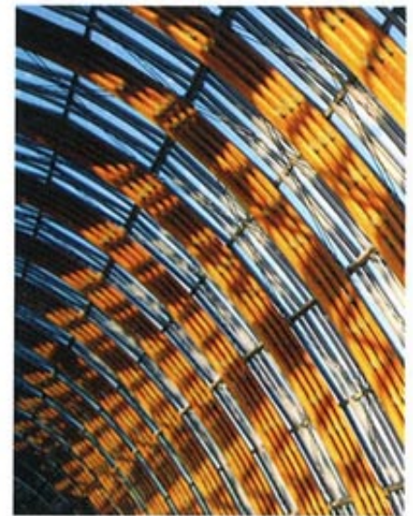
Bild 6. Innenansicht der Konstruktion (Foto: RPBW Paris)
