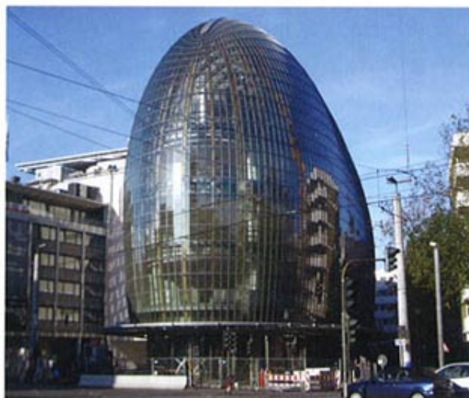
Bild 11. Außenansicht Fassade (Foto: RPBW Paris) Fig. 11. View of façade
