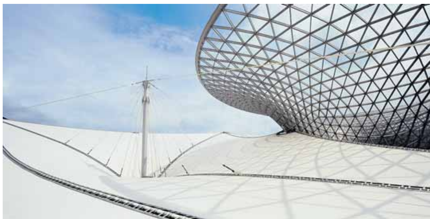
Von deutschen Ingenieuren entworfen: Das weltgrößte Dach aus einer textilen Membran hängt auf der Expo in Shanghai.
